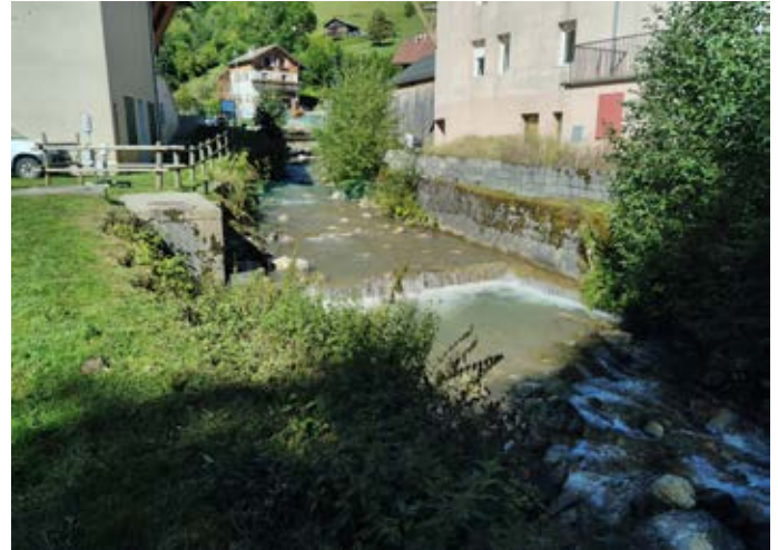
> Le seuil des enneigeurs avant travaux
