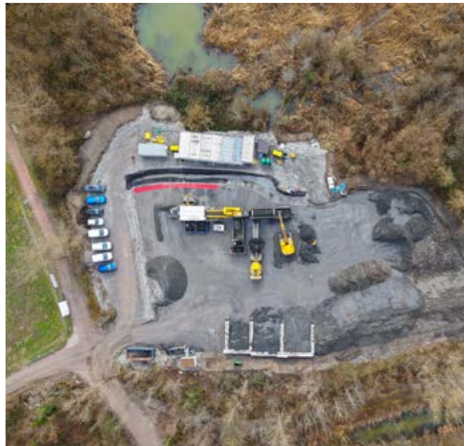
Zone de tri de la décharge RD14
