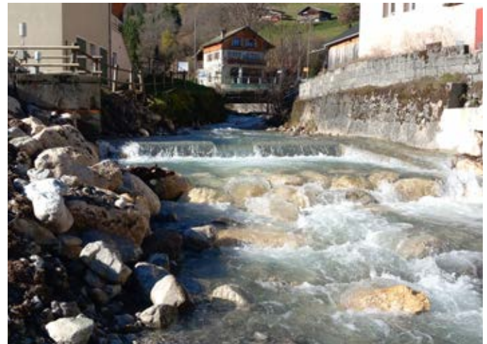
> Le seuil des enneigeurs après intervention
